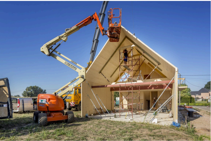
Een huis opgetrokken uit CLT in Berlaar. CLT, hout samengesteld uit op elkaar geplakte planken, kan wedijveren met beton en staal. © Joren De Weerd
