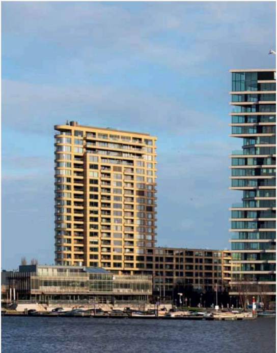
Met een hoogte van 73 meter is HAUT voorlopig het hoogste houten woongebouw ter wereld. Foto's: Lingotto
